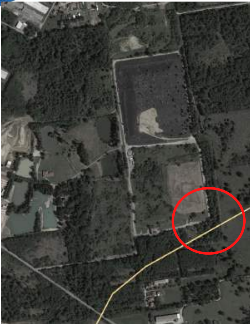
Discarica RSU in fase di chiusura dalla prog km 27+100 a km 27+250
